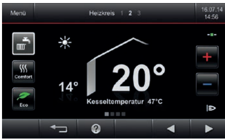
Renkli dokunmatik ekranlı kontrol paneli
